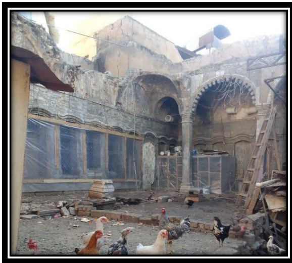
صورة رقم (١٢) بقايا مسجد شط الجومي
