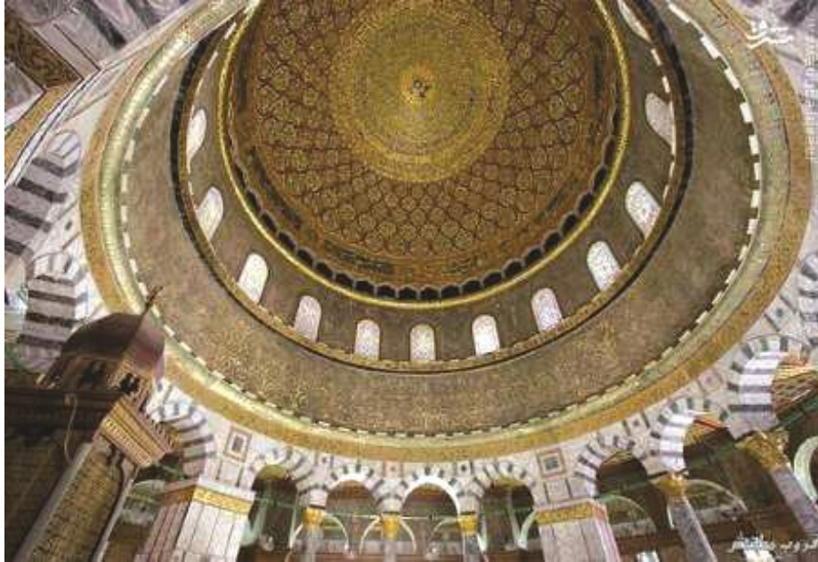
شكل (٣) الدائرة المركزية الحاملة للقبة
