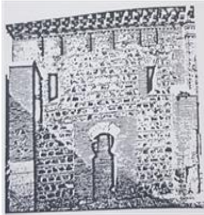
(شكل ٨) الواجهة الجنوبية الشرقية .
