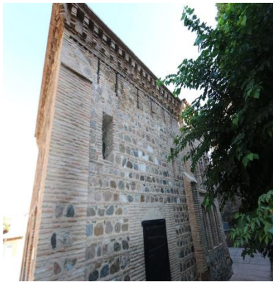
(لوحة ٢٢) الواجهة الجنوبية الشرقية بعد الترميم واختلاف مدخل من العقد المتجاوز الى عقد مستقيم
