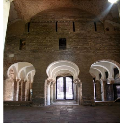
(لوح ٢٣) الواجهة الشمالية الشرقية
