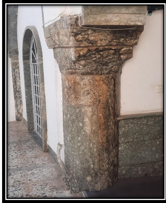
الصورة ٦ عمود مدمج تصوير الباحث
